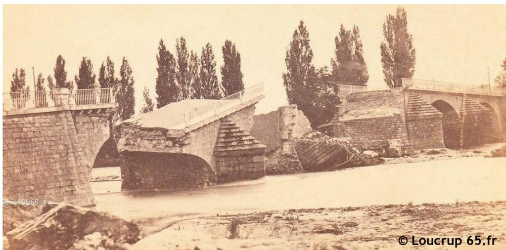
**Figure 11 - Démolition du pont de la Marne à Tarbes lors de la crue du 23 juin 1875 (plus forte crue répertoriée sur l'Adour amont)**
