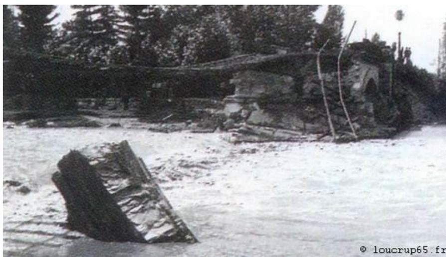
**Figure 12 - Démolition du pont ferroviaire à Tarbes lors de la crue du 3 juillet 1897**
