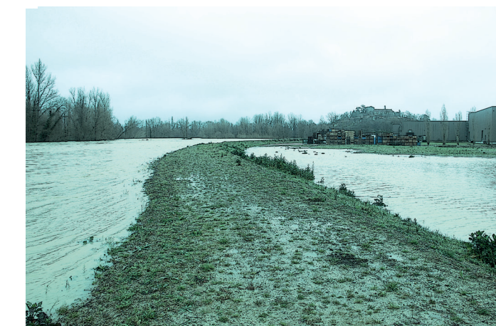
Digue de Saint Mont (32) pendant la crue de janvier 2014
