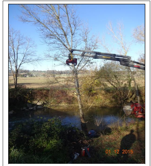
Utilisation combinée du double treuil et de la grue forestière pour les chablis ou embâcles inaccessibles depuis les berges.
