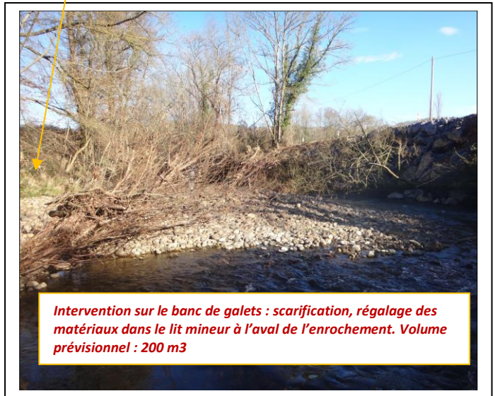
Accès par la rive gauche (pente douce). Intervention depuis le banc de galets avec pelle à chenilles pour limiter au maximum le déplacement dans le vif et travailler le plus à l'assec possible. Les matériaux seront régalez et mis en glacis en pied de berge opposé sur la rotation de la tourelle pour éviter le déplacement dans le lit vif du Lées.
