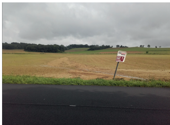
RN21, débordement en amont de Villecomtal-sur-Arros
