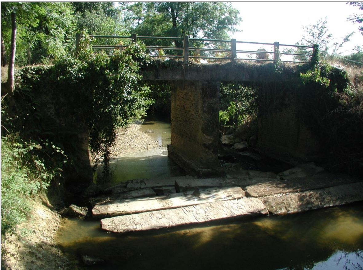
Signe de l'enfoncement du lit, 300 m en amont de l'affleurement, visible au niveau des piles du pont Coume (Maspie – 64 350)
