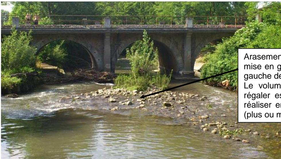
Arasement de l'atterrissement et mise en glacis des matériaux en rive gauche de l'Echez ;
