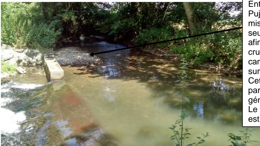
Entretien de la prise d'eau du canal de Pujol par arasement de l'atterrissement et mise en glacis des matériaux en aval du seuil du canal du Barrau, en rive droite, afin qu'ils soient mobilisables lors des crues (pour éviter l'assèchement du canal de Pujol qui se rejette dans l'Echez sur la commune de Vic en Bigorre) ;
