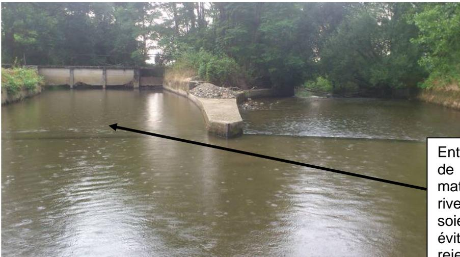
Entretien de la prise d'eau par arasement de l'atterrissement et mise en glacis des matériaux en aval du seuil de l'Echez, en rive gauche et en rive droite, afin qu'ils soient mobilisables lors des crues (pour éviter l'assèchement de ce canal qui se rejette dans le Lys et ensuite dans l'Echez sur la commune de Larreule) ; Cette intervention est à réaliser une fois par an (entre mi mai et mi juin en général).
