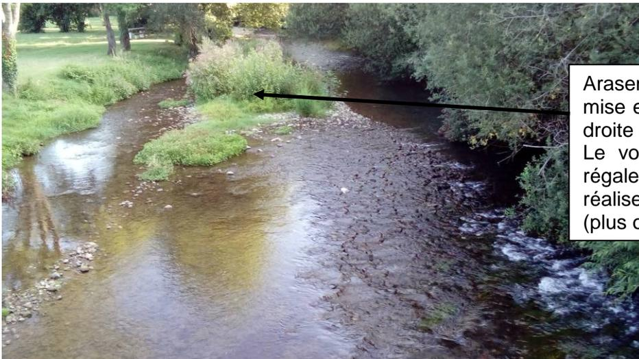
Arasement de l'atterrissement et mise en glacis des matériaux en rive droite de l'Echez en aval du pont ;
