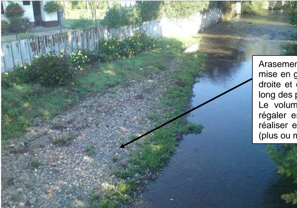
Arasement de l'atterrissement et mise en glacis des matériaux en rive droite et en aval, en rive gauche, le long des palplanches ;
