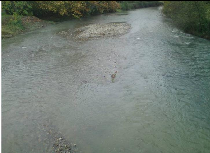
Le choix des techniques de traitement des structures alluvionnaires se fait en fonction de la configuration du site. De façon générale le traitement des bancs doit permettre de favoriser la remobilisation des matériaux.
