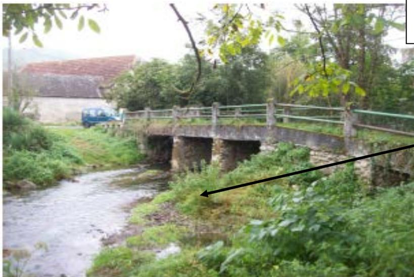
Arasement de l'atterrissement situé en rive gauche de l'Echez sous l'arche du pont et régaler des matériaux dans le lit de l'Echez en aval du pont afin de faciliter les écoulements en période de crue et que les matériaux restent mobilisable lors des crues ;
