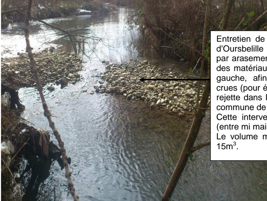
Entretien de la prise d'eau du canal de la Gaou d'Oursbelille (longueur du canal principal 1780ml) par arasement de l'atterrissement et mise en glacis des matériaux en aval du seuil de l'Echez, en rive gauche, afin qu'ils soient mobilisables lors des crues (pour éviter l'assèchement de ce canal qui se rejette dans le Souy et ensuite dans l'Echez sur la commune de Lagarde) ;
