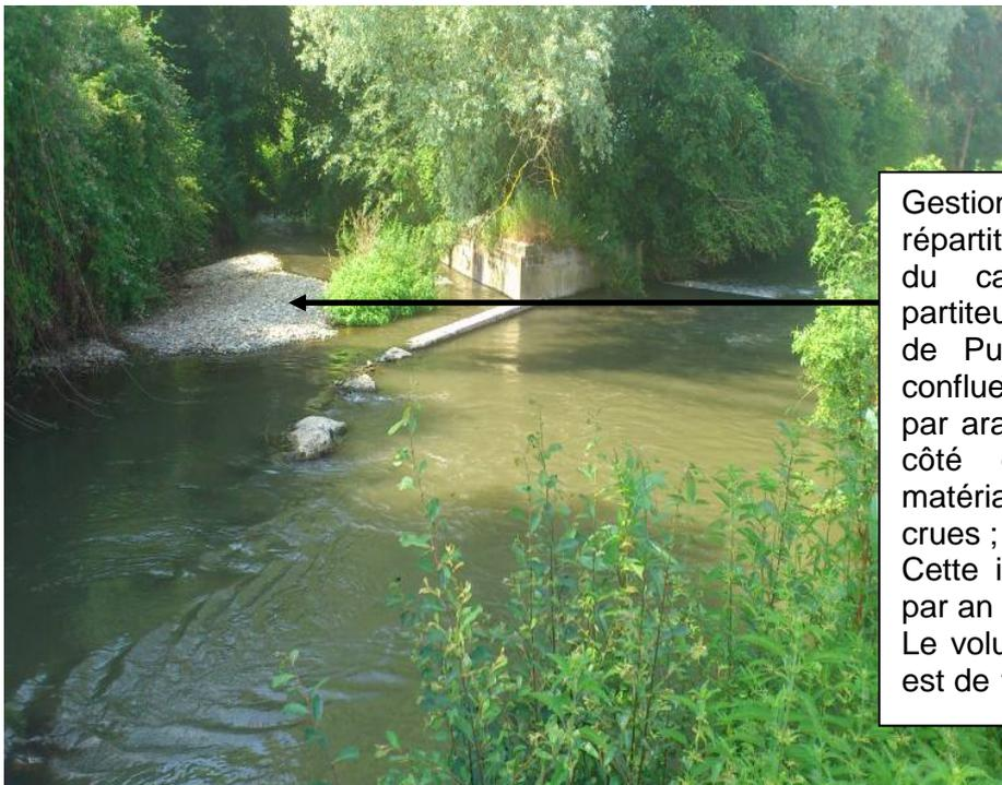
Gestion de l'atterrissement au niveau du répartiteur du canal d'Andrest (longueur du canal principal 4410ml jusqu'au répartiteur du Barrau qui alimente le canal de Pujo et plus de 12km jusqu'à la confluence avec l'Echez à Vic en Bigorre) par arasement et régalinge des matériaux côté canal d'Andrest afin que les matériaux soient mobilisable lors des crues ;
