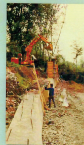
Travaux de réalisation du mur de protection de Maubourguet (65)
