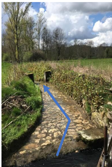
Début du canal de décharge
