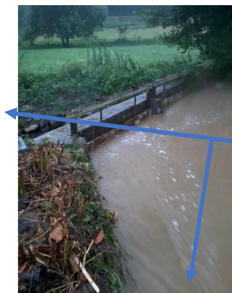
Mise en charge du canal de décharge le 16 juillet 2018
