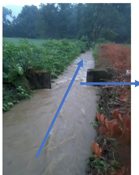
Ouvrage contribuant à l'inondation côté nord le 16 juillet 2018
